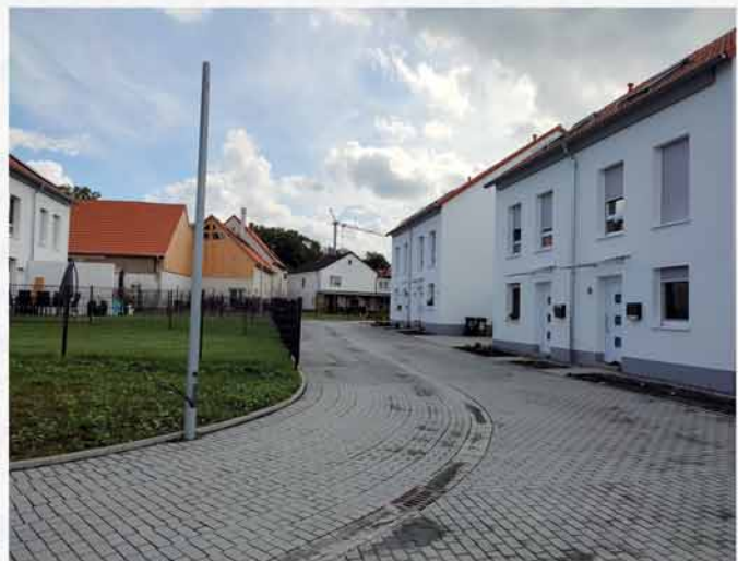
Ein Teil der Innenschließung im neuen Baugebiet ist bereits fertig gestellt. Die Zufahrt zur Sackgasse ist noch nicht fertig. Foto: C. Reichert-Rachor
