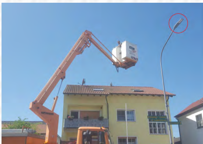
Was tut sich da in luftiger Höhe bei unseren Straßenlampen? Ein Monteur tauscht die Lampenköpfe aus, wie hier in der Berliner Straße in Mosbach: LED statt Gasdrucklampen
