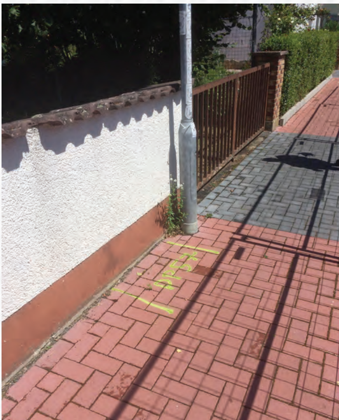
Bodenmarkierung für den Standort eines Kleinverteilers
