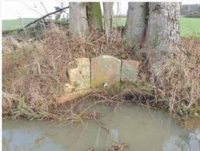
Das Krönisch'sbrunnchen in der Nähe des FSV-Sportgeländes heute im Jahre 2022, also 40 Jahre nach Erstellung: Der Wasserauslauf ist noch da, aber kein Wasser fließt mehr heraus. Davor nur angestautes Wasser, das wegen eines verstopften Ablaufrohrs nicht abfließen kann.
