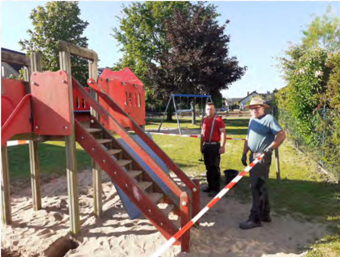
Die Bauhofmitarbeiter Gerhard Zahn und Erhard Schröder demontieren das alte Spielgerät
