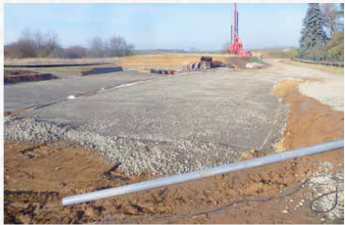
Arbeitsebene zur Erstellung der Bohrpfähle
